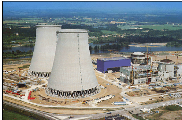
Fig. 2 – Torri di raffreddamento di una centrale termoelettrica: servono a smaltire il calore ceduto dal ciclo termodinamico dissipandolo nell'ambiente.
